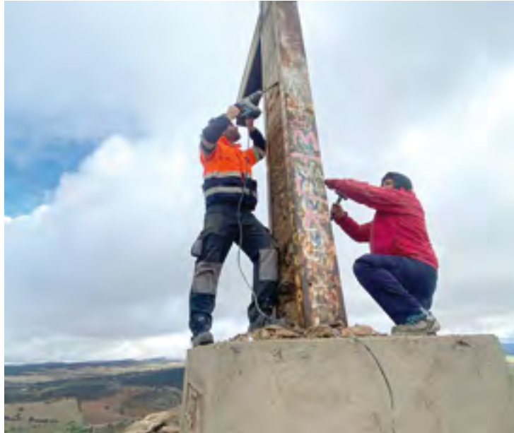
Trabajos realizados en la cruz
